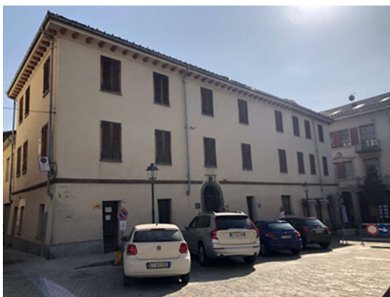
Vista prima dei lavori
