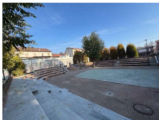
Vista a lavori eseguiti
