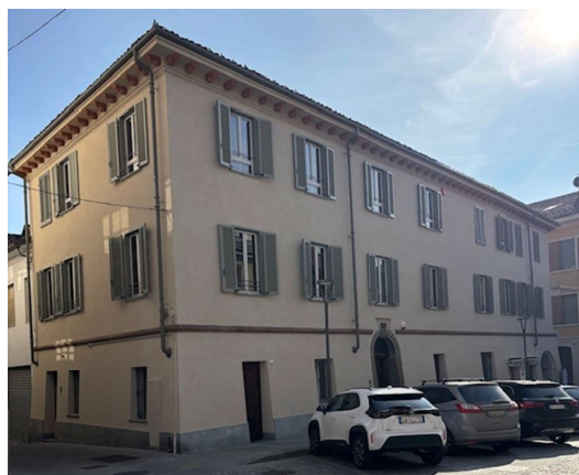
Vista a lavori eseguiti
