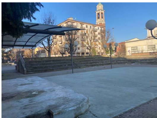
Vista prima dei lavori
